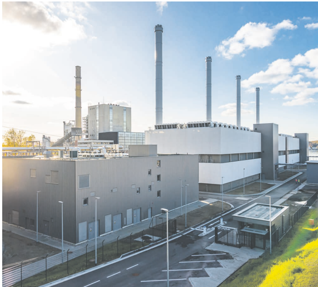
Gewaltige Power: Das Küstenkraftwerk ist das modernste Gaskraftwerk Europas.
